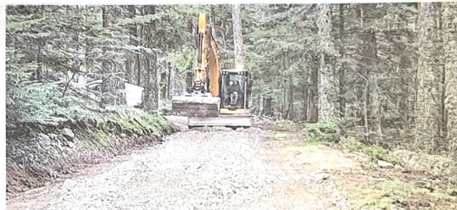
La remise en bon état des chemins forestiers était indispensable pour le travail des forestiers, et leurs usages multiples en général. Photo Suzanne Drevet
